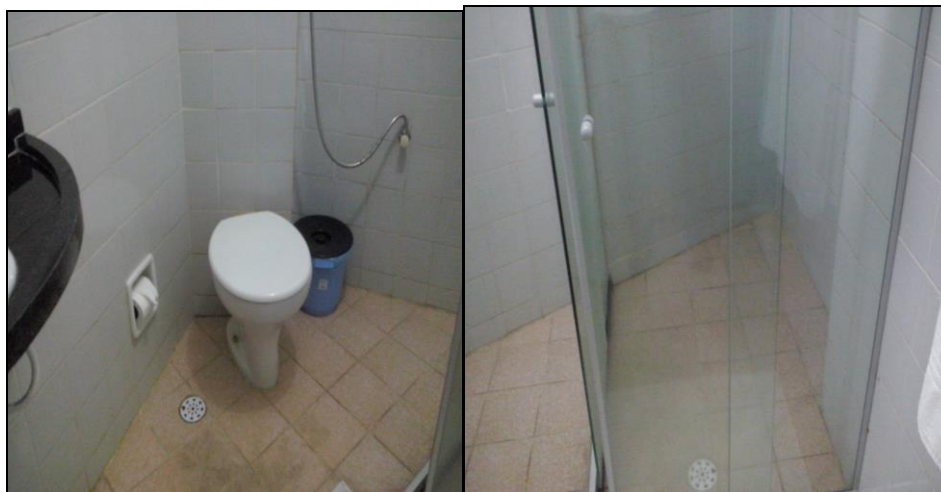
Figura 6 e 7 – Banheiro sem acessibilidade em hotel de médio porte
