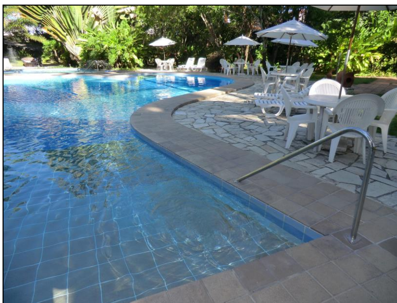
Figura 13 – Piscina com rampa submersa
