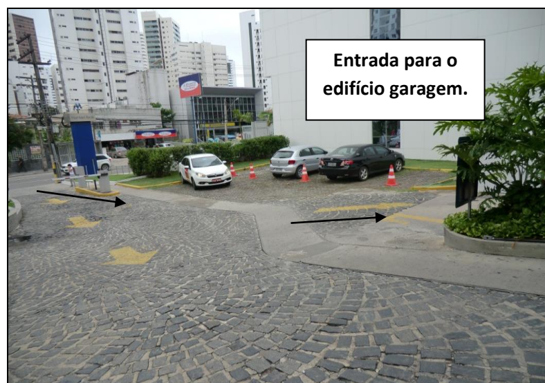
Figura 1 – Entrada do edifício garagem do Sea hotel
